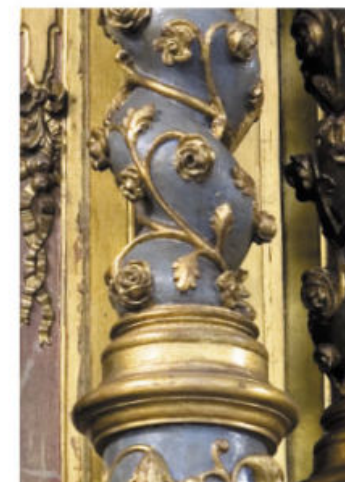
FIG. 1.48 La columna salomónica es un sostén con cuerpo retorcido. Se llama así porque se creía que el templo de Salomón tenía este tipo de columnas.
