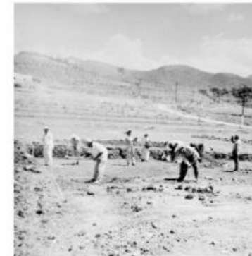
FIG. 4.41 Al principio, el acondicionamiento de los caminos se hacía sólo con cuadrillas de hombres y poca maquinaria.
