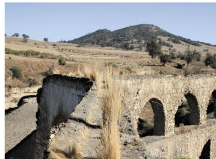
FIG. 1.49 Para abastecer de agua a ciudades, como la de México, Querétaro o Zacatecas, se construyeron acueductos, igual al que muestra la imagen.
