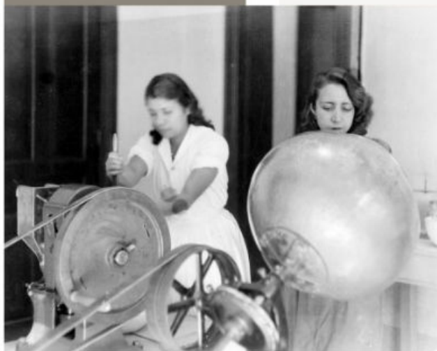
FIG. 4.50 Mujeres operan maquinaria industrial en una fábrica.
